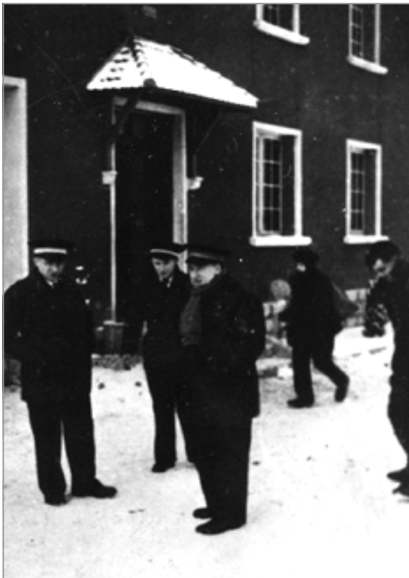
La maison des pilotes - 1939 (collection S.H.D.)
